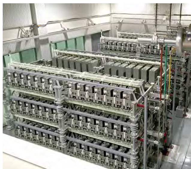
Рис. 5 UPFC преобразовательный вентиль
