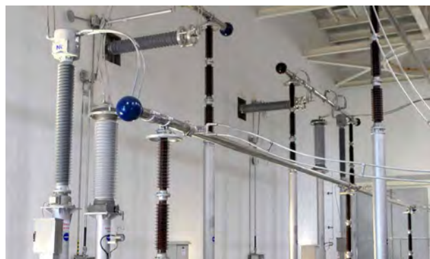
Электронная ТТ Чжоушаньского 5-конечного проекта VSC-HVDC
