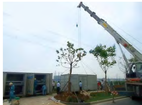
Рисунок 5. Установка BESS
