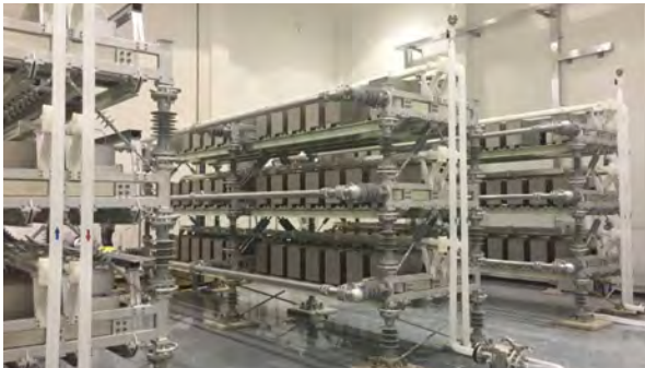
Рис. 2. Фотография на внутренней части STATCOM
