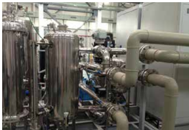
Рис. 4 Система охлаждения
