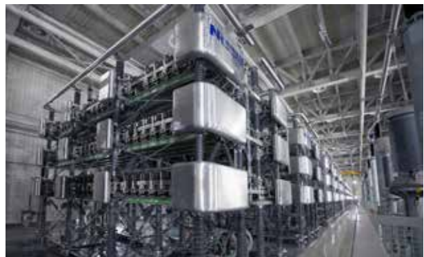
Рис. 4 TBS для проекта 500kV UPFC в Сучжоу, Китай
