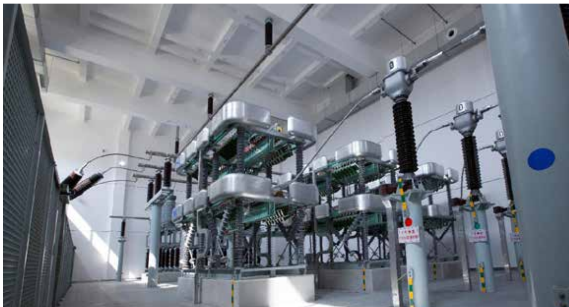
Рис. 4 TBS для проекта 500kV UPFC в Сучжоу, Китай
