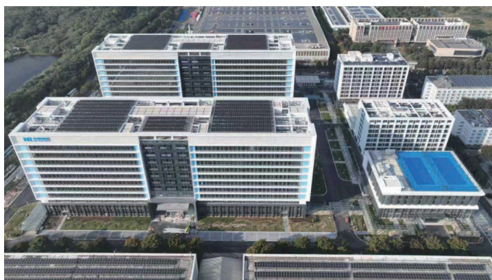
将军路二期屋面太阳能热水系统俯瞰图
