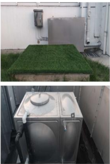
改造后现场照片
